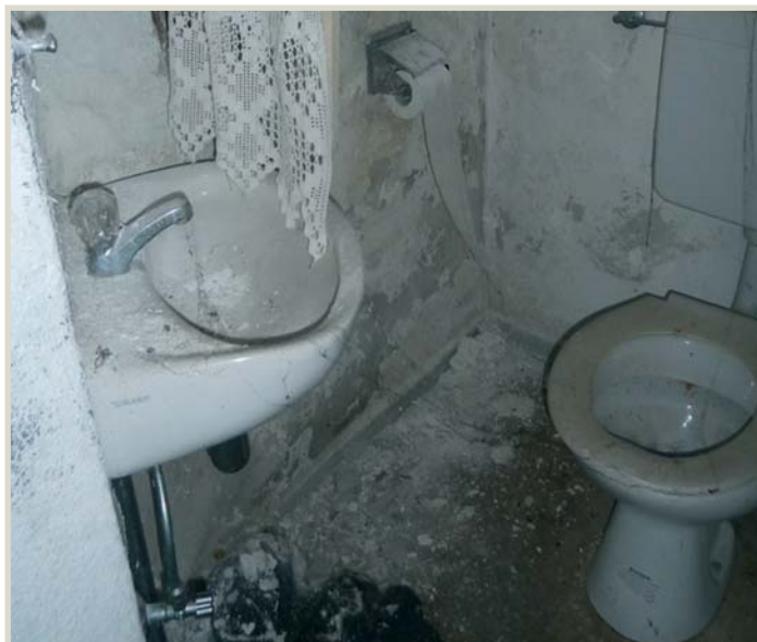
Gemeinsame Toilette i.d. Stadtmauer
