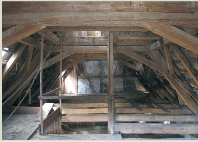
Holzkonstruktion der oberen Stockwerke der Scheune
