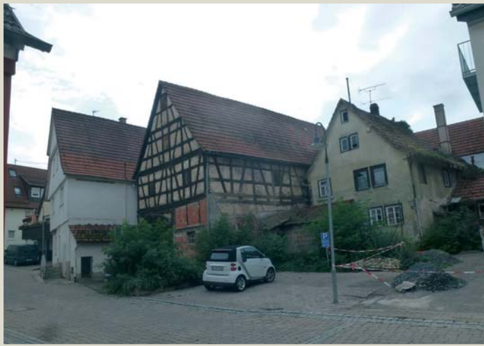
Obere Gasse: Haus Arnold Nr. 10, Scheune Nr. 8, Haus Kimmich Nr. 6
