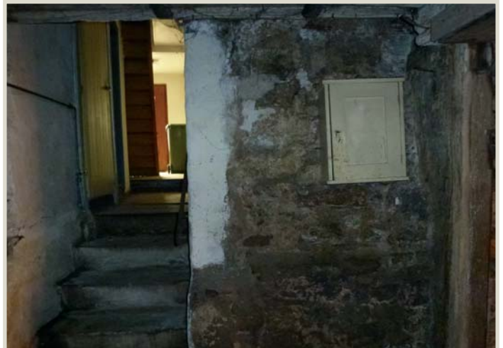
Durchgang in der Stadtmauer von Haus Kimmich, Obere Gasse 6, zu Haus Schüle, Zwingerstraße 5
