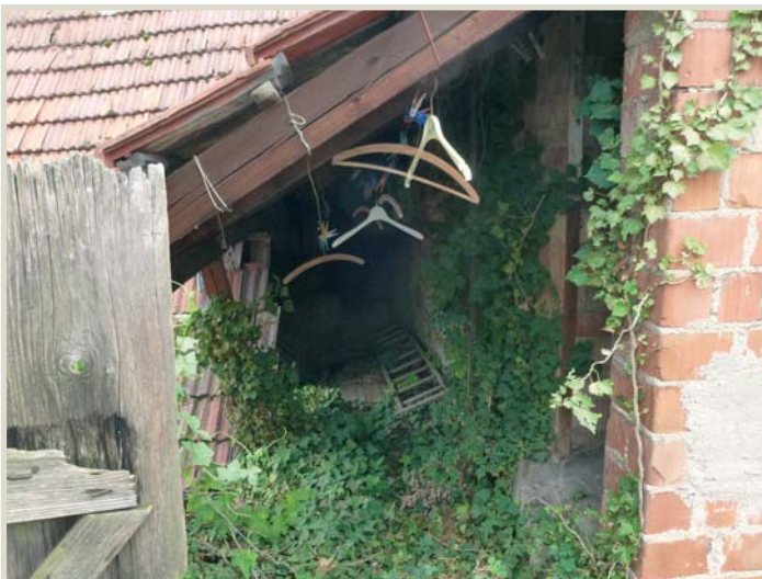
Stadtmauer als Wäscheplatz mit Zugängen von 3 Gebäuden
