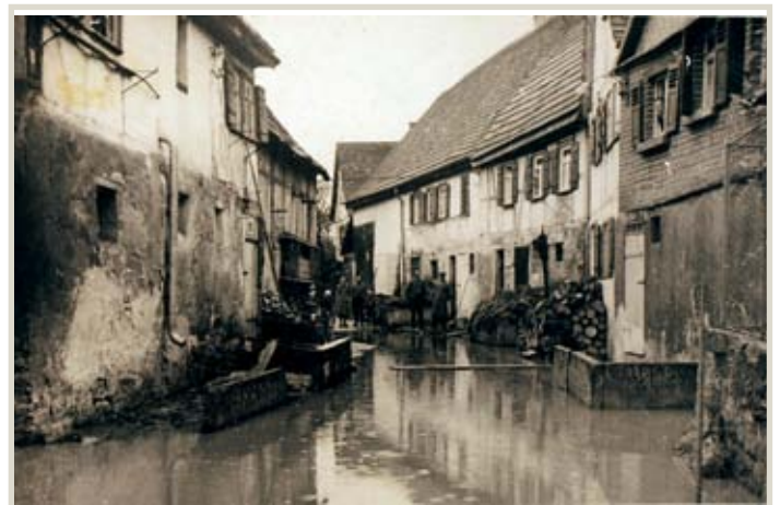
Am Fenster vom dritten rechten Haus schaut "Hohn's Marie" heraus Land unter in der Enzgasse
