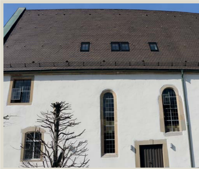
Westteil, die ältere Dachhälfte ca. bis zum Fallrohr der Regenrinne.
