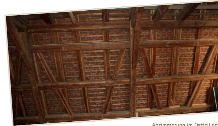
Abzimierung im Ostteil der Kirche (jünger zum Turm hin)
