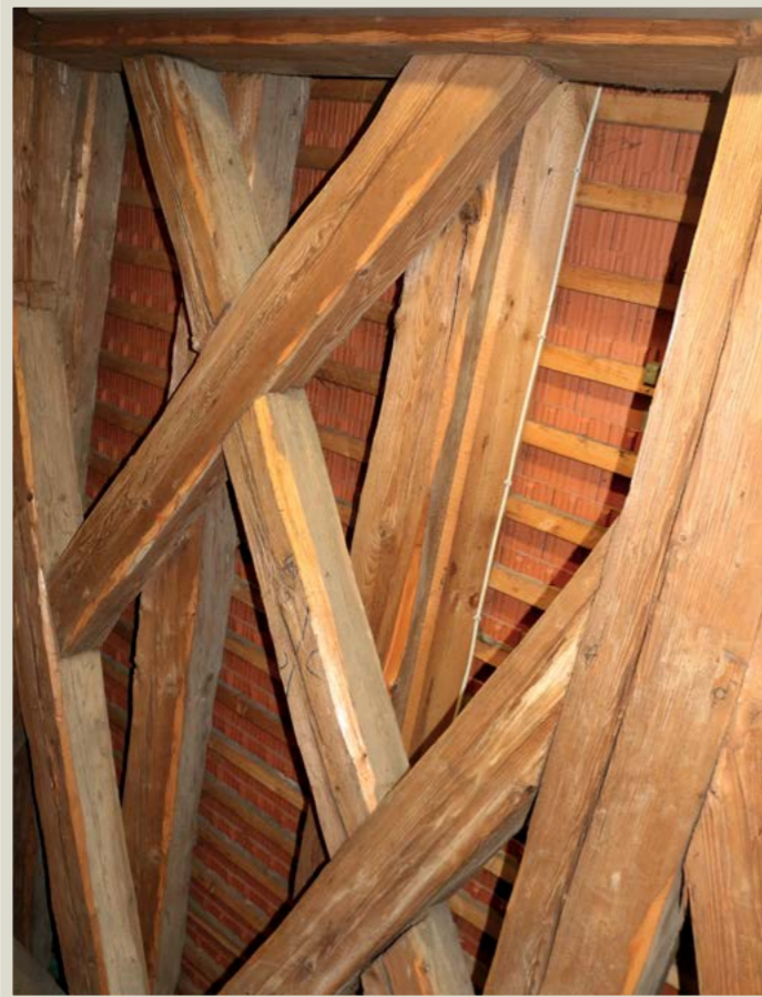
Abzimierung im Westteil der Kirche (älter)
