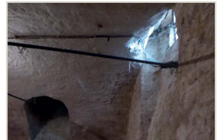
Gewölbter Lüftungsschacht an der östlichen Gewölbewand
