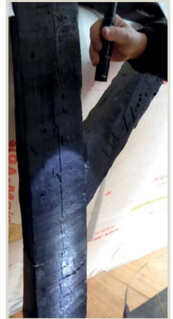
Albrecht Noller im Kriechkeller über dem Kellergewölbe mit Stalleinbau, darüber EG Decke, hier gibt es Floßblöcher.
