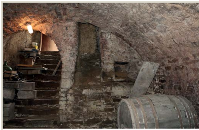
Luftschacht mit Stroh rechts der Treppe, gemauerte Nische mit der Fassdichte daneben
