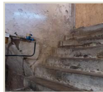
Die 6 obersten Stufen des Treppenabgangs zwischen Hauswand und Kellergewölbe entsprechen der Breite des „Franzosenlochs“
