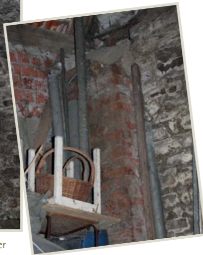
Luftschacht mit Stroh rechts der Treppe, gemauerte Nische mit der Fassdichte daneben
