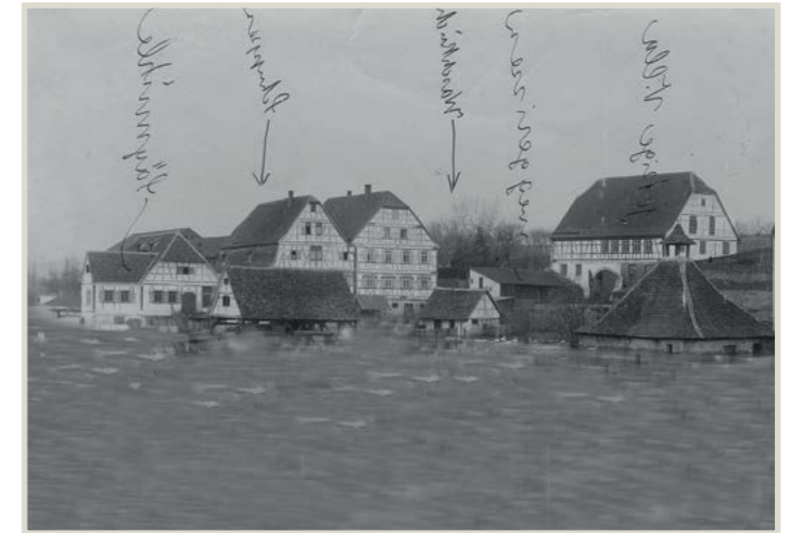
Alte Mühle und Waschhaus im Hochwasser nach 1832 vor 1897
