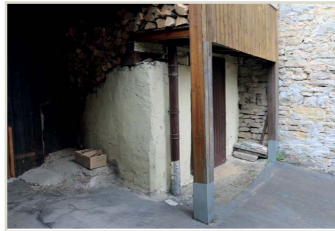
Kellereingang vorn, durch die braune Türe, links hinter der kleinen braunen Türe entlüftet der Luftschacht, der innen neben der Treppe ist
