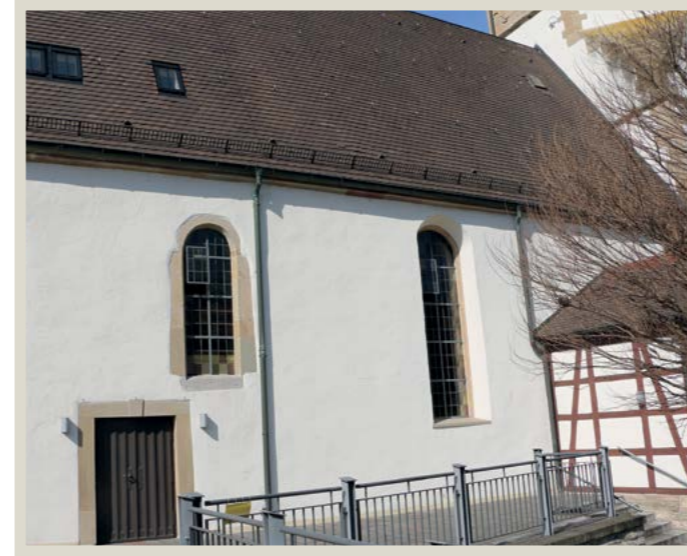
Ostteil, die jüngere Dachhälfte, rechts vom Fallrohr
