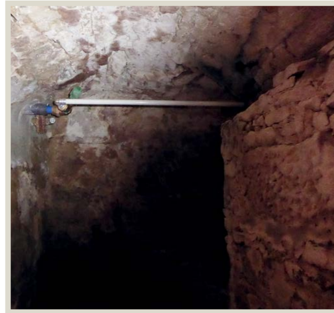
Unterbrechung des Kriechgewölbes unter der Treppe, rechts der Zugang
