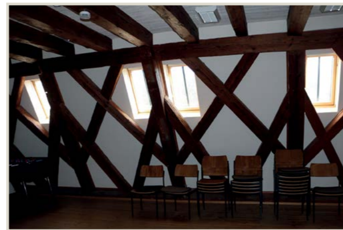
ehemals geschlossener Raum im Dachboden
