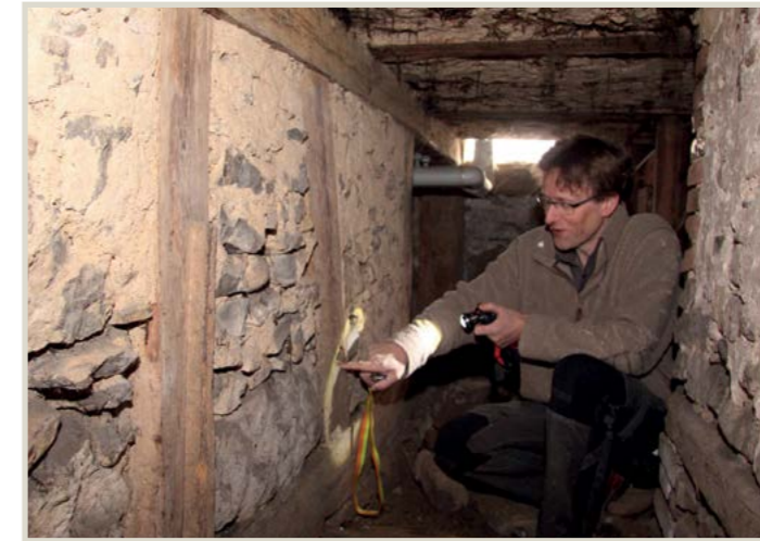
Albrecht Noller im Kriechkeller über dem Kellergewölbe mit Stalleinbau, darüber EG Decke, hier gibt es Floßblöcher.
